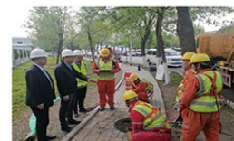
在项目现场进行安全检查
